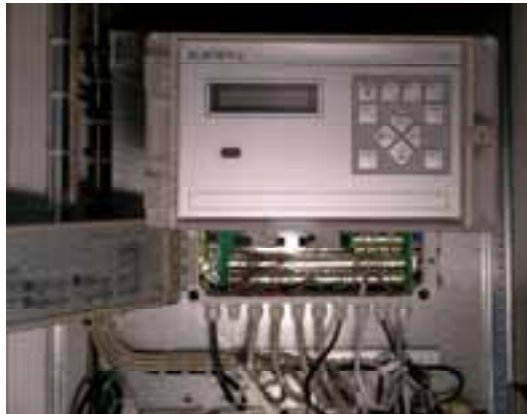
УСПД RTU-325 с открытой крышкой клеммного отсека
